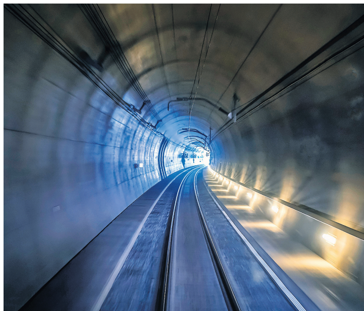
La galleria finisce ma l'opera no.
