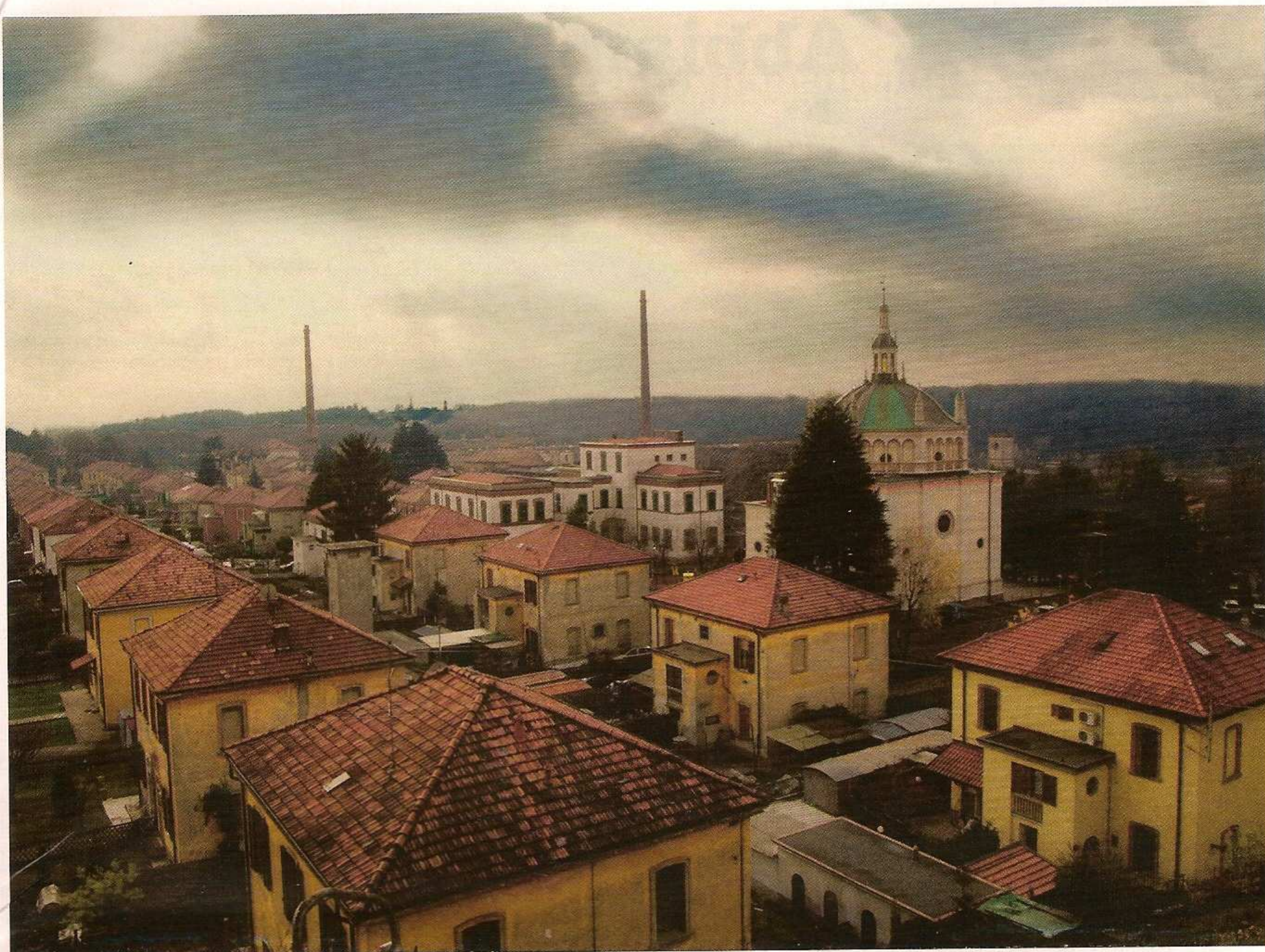
Veduta dall'alto del villaggio con le residenze degli operai. Tutte le case hanno un piccolo giardino che gli operai adibivano a orto
