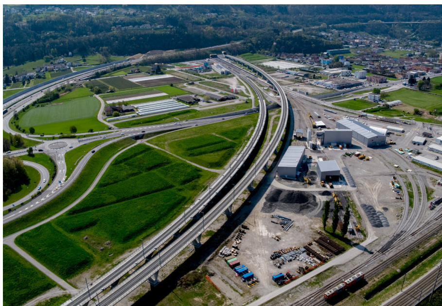
Veduta panoramica del portale nord della galleria di base del Ceneri.
